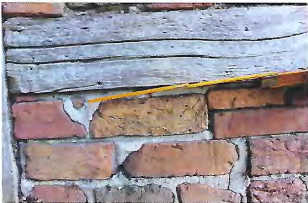
Einige der im Back- und Waschhaus verbauten Klostersteine Foto: Speckmann
